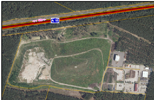
Abb. 4-1 Übersicht zur Deponie Forst-Autobahn
