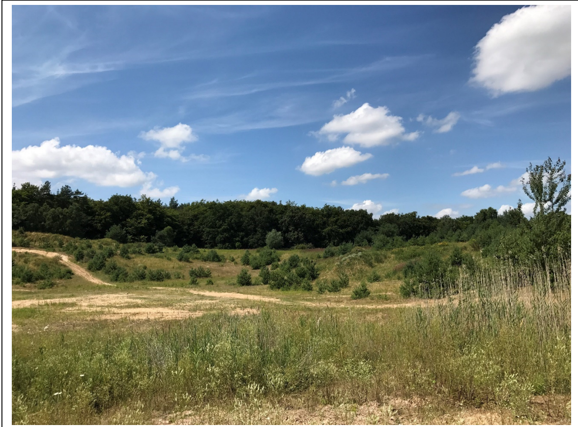
Blick auf die Nordwestböschung, dahinter Tagebauvorfeld
