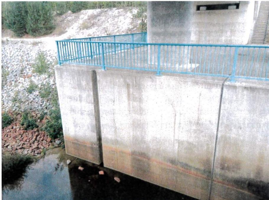
Abbildung 16: Vorhandene Nische am Kombibauwerk für neue Pegellatte
