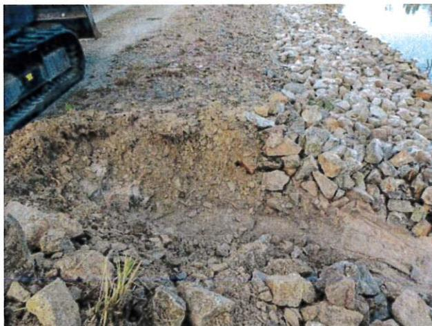
Abbildung 7: Deckwerksaufbau – Wasserbausteine und Mineralgemisch [10]
