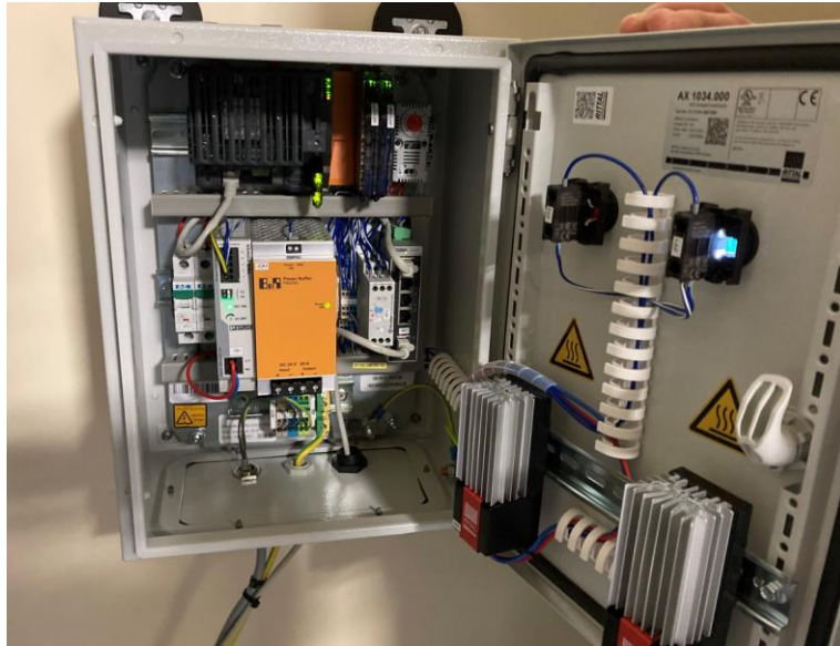
Abbildung 11-2: Innenansicht SMU Modul des Schattenwurfschutzsystem
